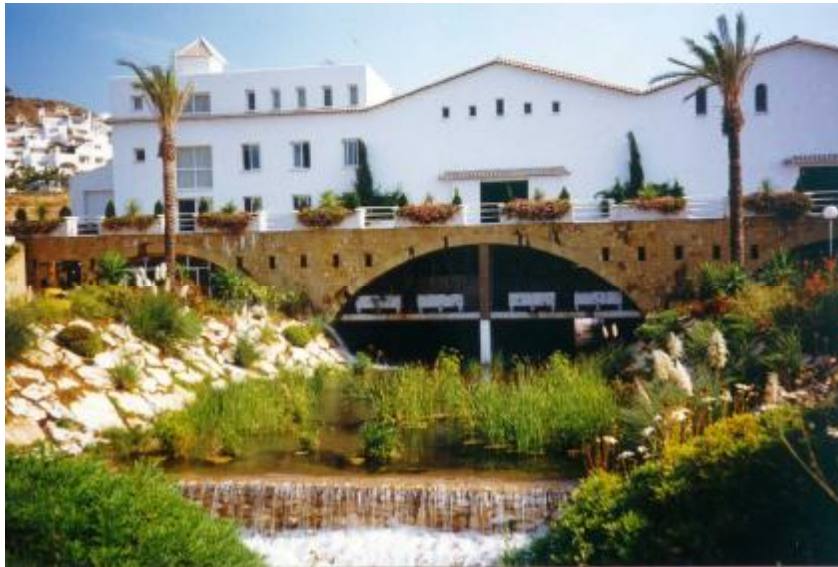
Planta desaladora de la Costa del Sol (58.000 m 3 /d) Cortesía de Decosol
