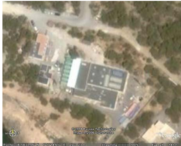
Figura 3. Vista general de la Planta Desaladora de Sant Antoni de Portmany
